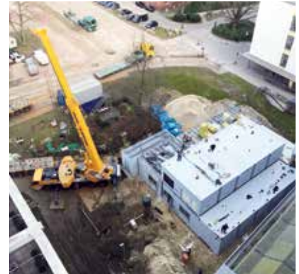
Zügig wurden die großen Module mit Hilfe eines Krans zusammengefügt
