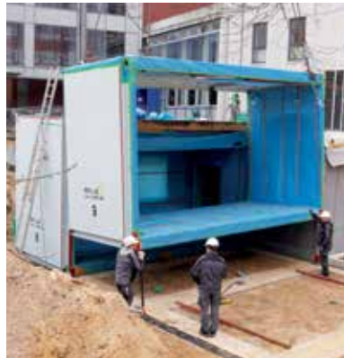
Zügig wurden die großen Module mit Hilfe eines Krans zusammengefügt
