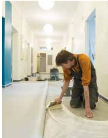
Zuletzt wurde der Fußboden verlegt
