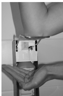
Geben Sie Desinfektionsmittel auf Ihre Handfläche. Bedienen Sie die Armhebelgar-nitur grundsätzlich mit dem Ellenbogen!
