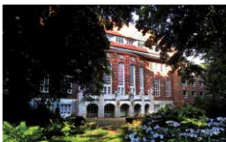
Altes Schwesternwohnhaus (Erika-Haus, N29)
