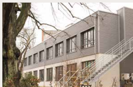
Erweiterung in Modulbauweise: Im oberen Stock liegt die neue Station 5 mit direktem Zugang zur Martini-Klinik
