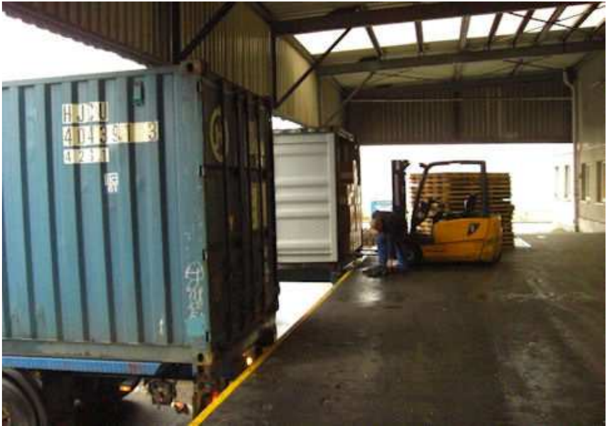
Abb. 1: Frei belüftete Rampe
