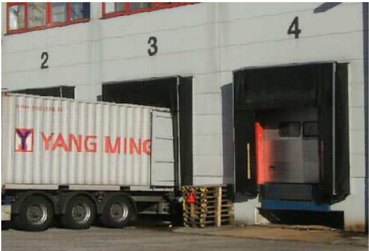
Abb. 2: Andockstellen mit „guter“ Abdichtung
