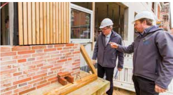
Züblin-Bauleiter Nick Niemann (r.) und UKE-Projektleiter Eike Deuter besprechen die Fassadengestaltung
