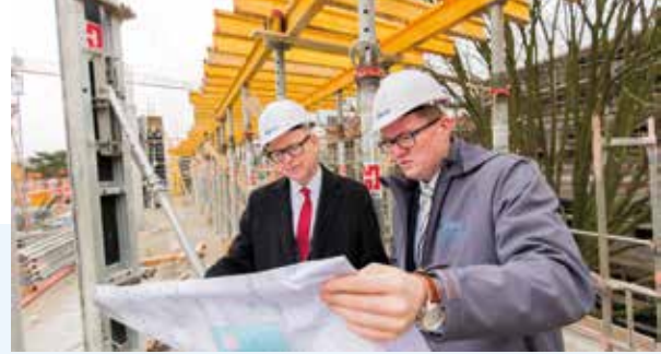
Rainer Schoppik (l.), damaliger Kaufmännischer Direktor, erkundigt sich nach dem Baufortschritt
