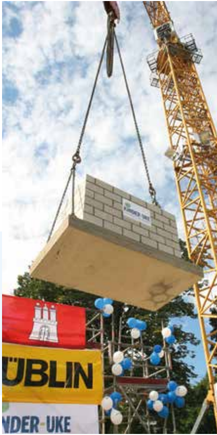
Der Bau ist im Zeitplan
