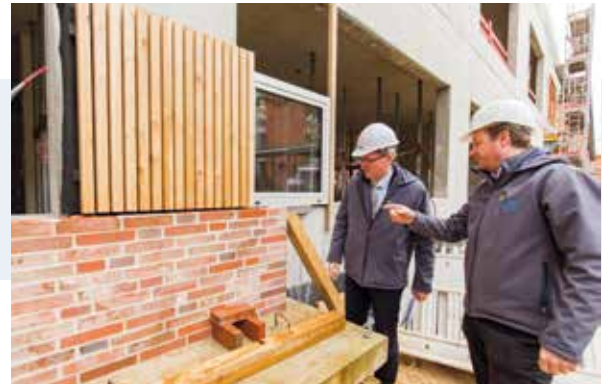
Züblin-Bauleiter Nick Niemann (r.) und UKE-Projektleiter Eike Deuter besprechen die Fassadengestaltung
