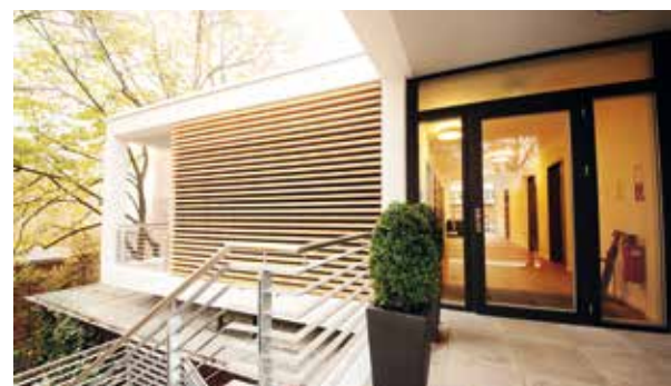
Der Eingangsbereich des UHZ-Baumhauses
