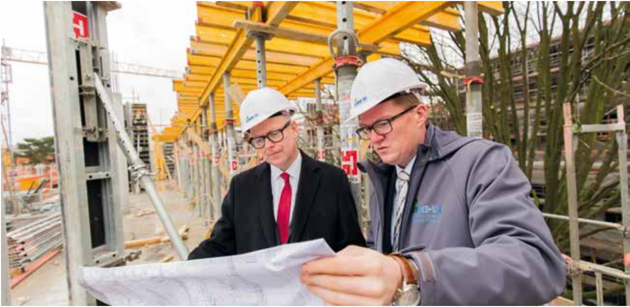
Rainer Schoppik (l.), Kaufmännischer Direktor und UKE-Vorstandsmitglied, erkundigt sich regelmäßig vor Ort bei Projektleiter Eike Deuter über den Baufortschritt der neuen Universitären Kinderklinik
